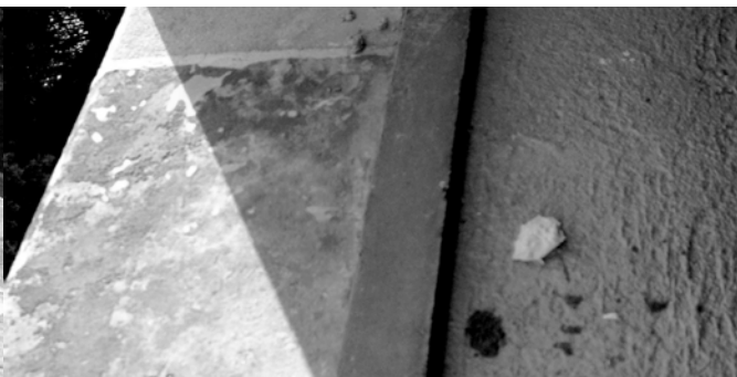
Mise en oeuvre du rejoint
