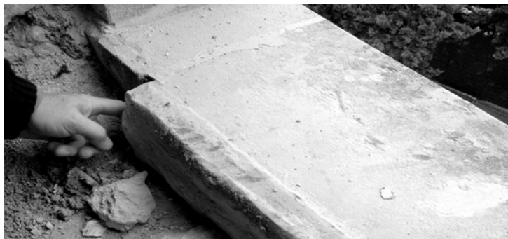
Reprise des appuis de baies pour mise en conformité
